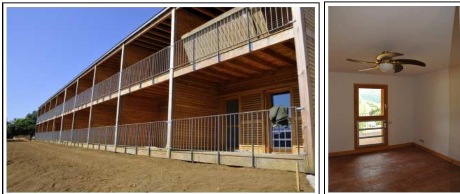
(a) Façade Est.
